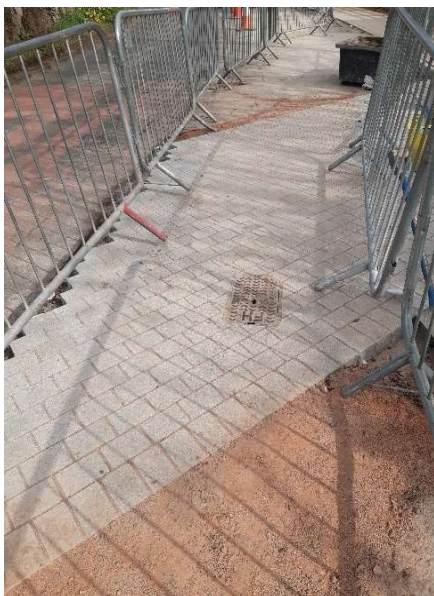
I'r chwith ac isod: Sets gwenithfaen ar draws y ffordd ger Eglwys y Santes Fair a Pharc Gwledig Cil-y-coed
